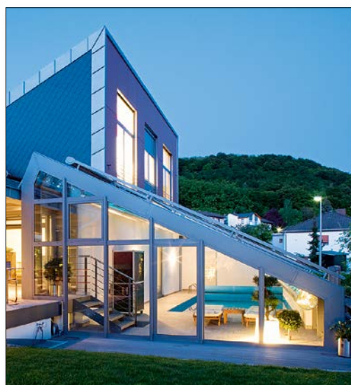
Verande con elementi scorrevoli che collegano casa e giardino
